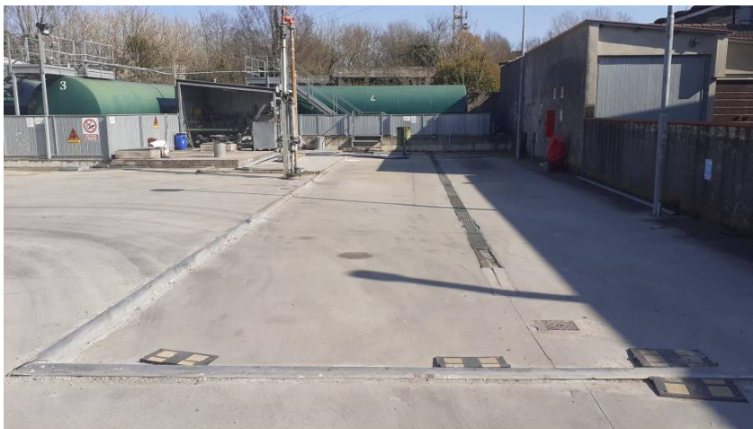
Figura 2.14– Porzione del deposito. Sono visibili i serbatoi 3 e 4, la bandiera per il carico dell'olio sulle autocisterne che lo avviano al recupero, il cordolo per contenere eventuali fuoriuscite di olio durante le operazioni di carico e scarico
