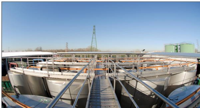
Figura 2.9: panoramica del parco centrale serbatoi
