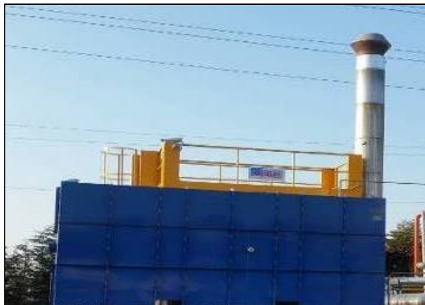
Figura 8.4– Sistema di abbattimento a postcombustore
