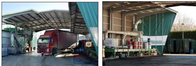
Figure 2.11 e 2.12 – Particolari dell'area coperte per lo scarico dei fusti di olio ed emulsione e del sistema di aspirazione vapori dedicato
